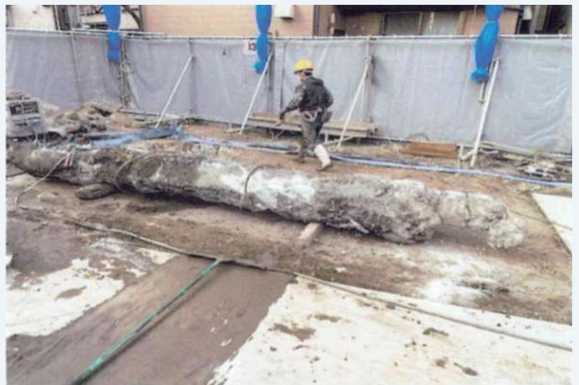
アースドリル機で引抜いた杭 本体
