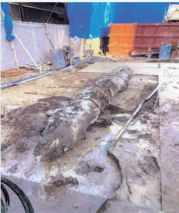
アースドリル機で引抜いた杭 本体
